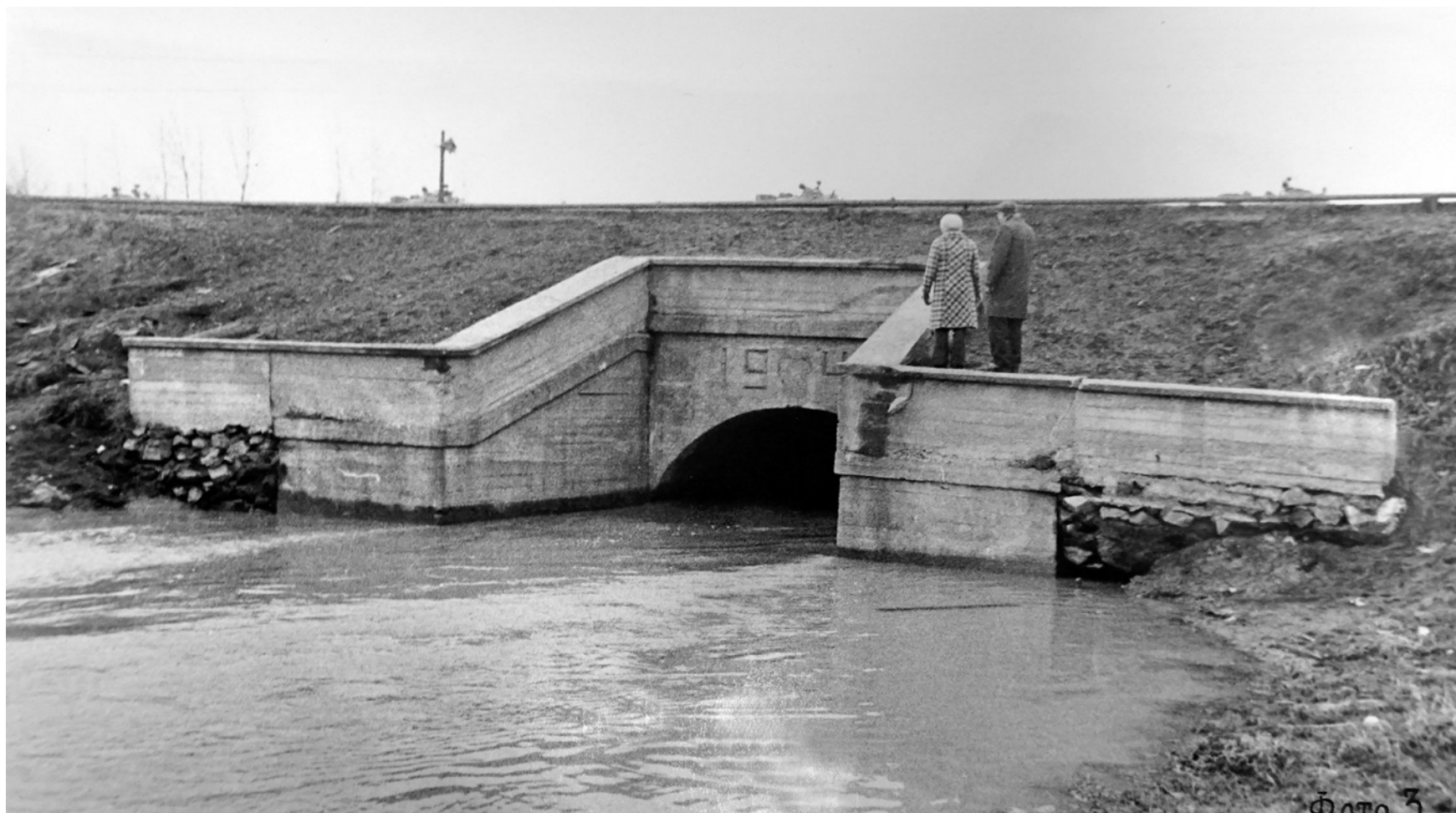
Водопроектная труба реки Дудергофка, под железнодорожными путями, 1979 год, вид со стороны пр. Народного Ополчения Фото предоставлено Галиной Борисовной Елпидинской / Из архивов «Ленмосттреста» (сейчас СПб ГБУ «Мостотрест»)
