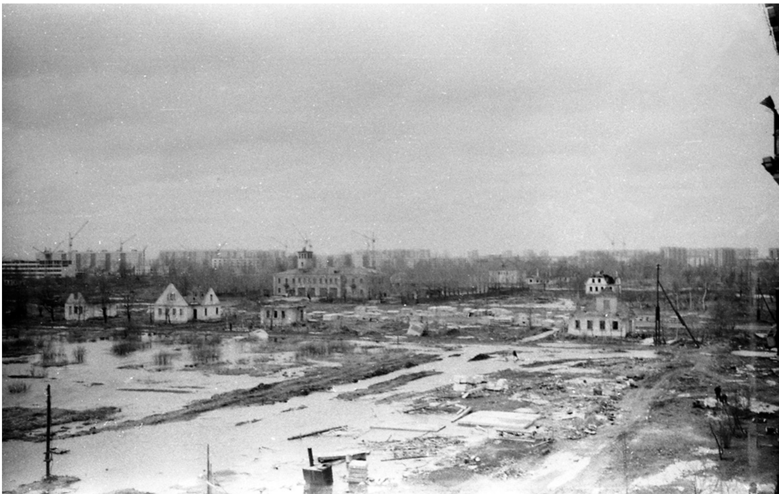
Вид с балкона дома 12 по ул. Партизана Германа, в центре снимка бывшая улица Карла Маркса с полуразрушенными одноэтажными домами, 1969 год Источник: сайт www.ligovo-spb.ru
