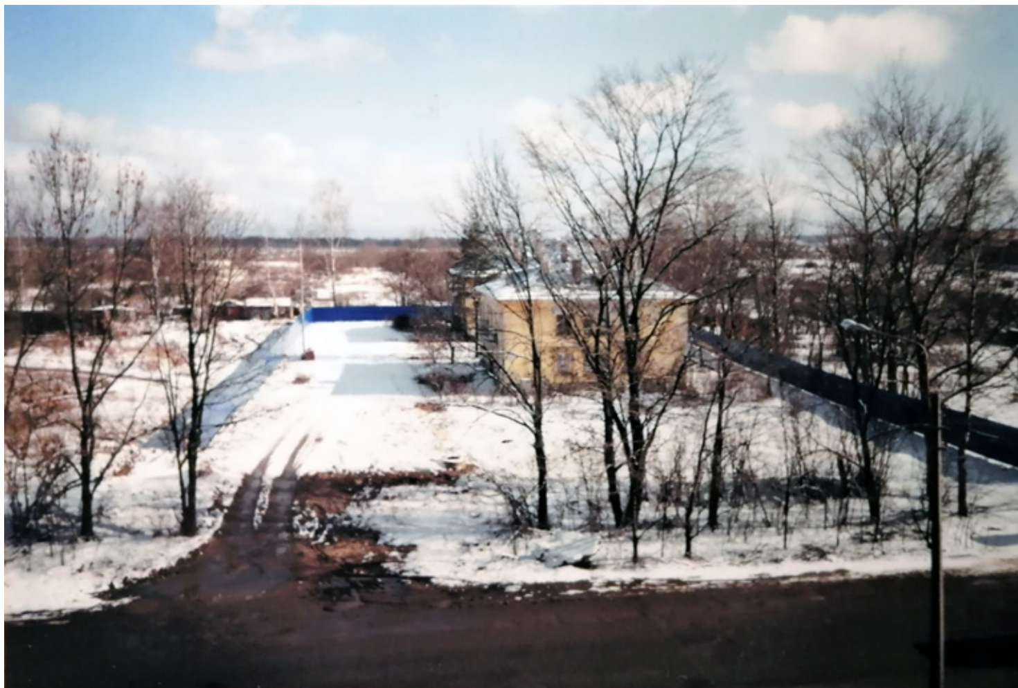
Начало строительства нового жилого квартала на Гатчинском шоссе, синим забором обнесены участки для строительства, 2008 год Фото предоставлено Зинаидой Егоровной Сутко
