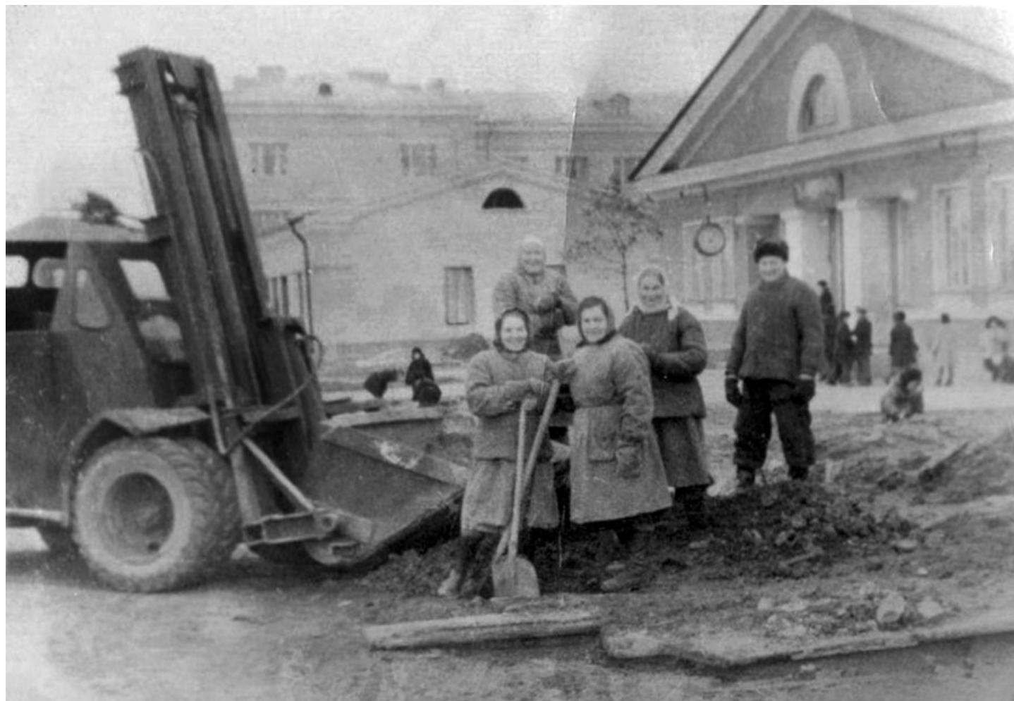
Баня № 68 по адресу: 2-я Комсомольская ул., 27, корп. 3. Завершено строительство, идет благоустройство прилегающей территории, 1959 год. Фото предоставлено Галиной Ивановной Ступицкой
